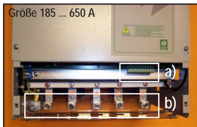
Abbildung 2.4.1: Klemmenlokalisierung
