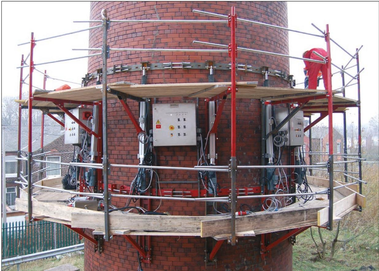
Réglage d'une plate-forme d'entretien à l'aide du vérin à forte capacité SLZ 90.
