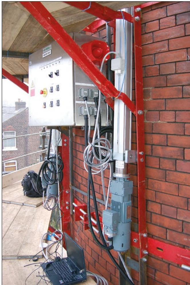
Réglage d'une plate-forme d'entretien à l'aide du vérin à forte capacité SLZ 90.
