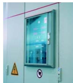
Fenêtre montée sur une armoire TS 8.
