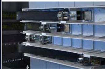
Jeux de barres totalement isolés, avec protection intégrale contre les contacts accidentels.
