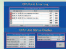
Écran de surveillance de l'unité centrale API
