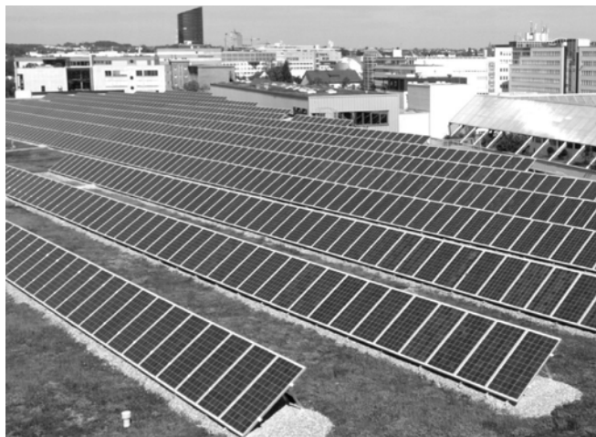
L'installation photovoltaïque de 168 kW sur le toit du centre Logistique du groupe Lapp à Stuttgart, Allemagne
