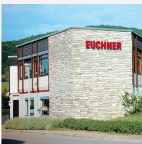
Site de production Unterböhringen
