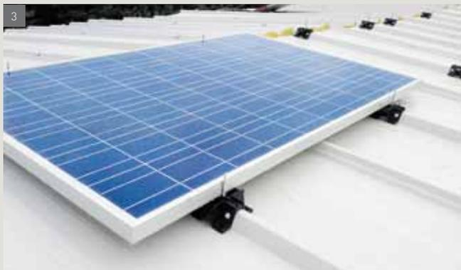
On commence donc à positionner les différents panneaux qui constituent les différentes lignes de strings photovoltaïques. (Installation photovoltaïque réalisée par General Building SpA, Polverigi, Ancône, Italie).
