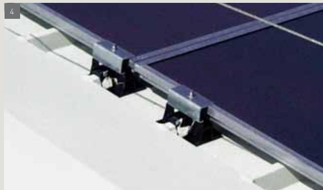
La ligne de strings est arrêtée en disposant les supports finaux sur le périmètre. Le câblage intermédiaire de chaque ligne de strings, comme le raccordement de cette dernière au reste de l'installation, est exécuté et assuré avec les connecteurs photovoltaïques volants CABUR. (Installation photovoltaïque réalisée par Energy Resources srl, Ancône, Italie).
