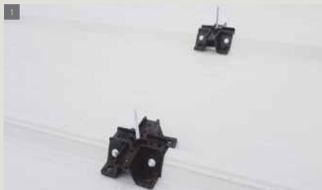
Les supports sont ancrés sur les profils à la grecque des panneaux avec des vis perforantes et autotaraudeuses à des distances réciproques dépendant des dimensions du différent panneau photovoltaïque. (Installation photovoltaïque réalisée par General Building SpA, Polverigi, Ancône, Italie).
