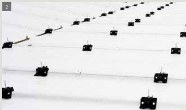
La présence des profils à la grecque assure un alignement facile et rapide des supports. (Installation photovoltaïque réalisée par General Building SpA, Polverigi, Ancône, Italie).
