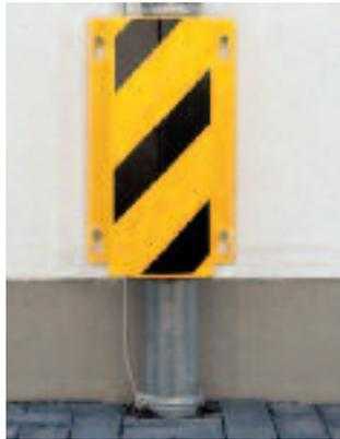
Permet de protéger les tuyaux, les conduites, les faisceaux de câbles, etc. des dégâts consécutifs à une collision.
