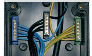
Les borniers enfichables isolés permettent un raccordement rapide et en toute sécurité et un câblage propre.
