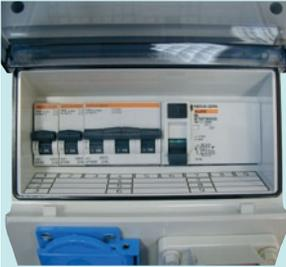
L'appareillage de protection est accessible derrière une fenêtre transparente, étanche en position fermée et verrouillée.
