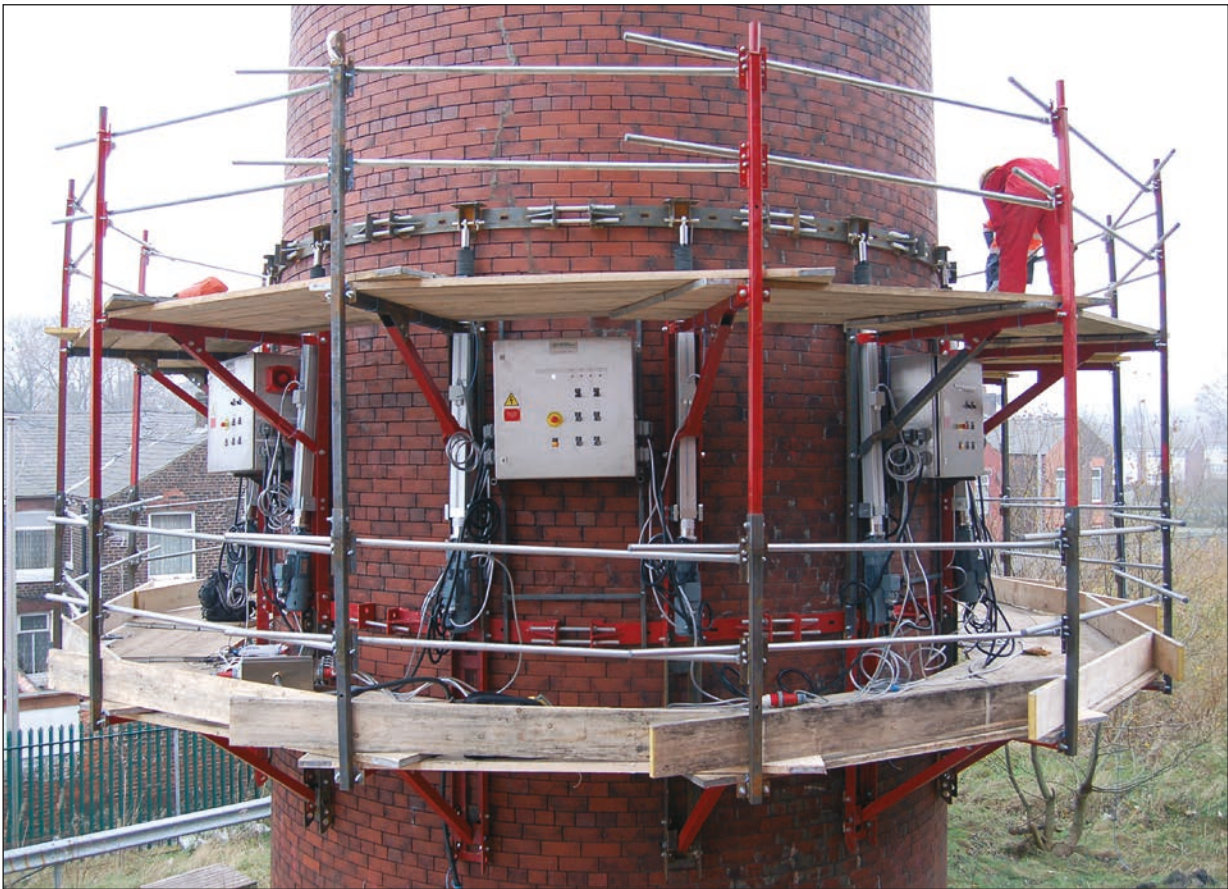
Réglage d'une plate-forme d'entretien à l'aide du vérin à forte capacité SLZ 90.
