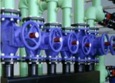
Le transport de l'agent de refroidissement est assuré par des pompes avec régulation de la vitesse de rotation.
