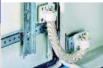
**Bandeaux de montage perforés** intégrés dans la porte pour fixer rapidement traverses de montage, goulottes de câbles et autres accessoires.
