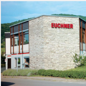
Site de production Unterböhringen
