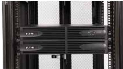
*Onduleur Eaton de 2U de hauteur avec module batterie de 2U également*
