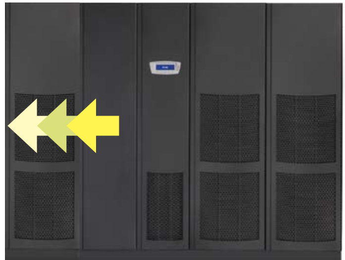
Ajout, sur site, d'un module de 275 kVA sur un 9395 550kVA
