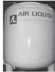
Réservoir d'azote pour le système de refroidissement
