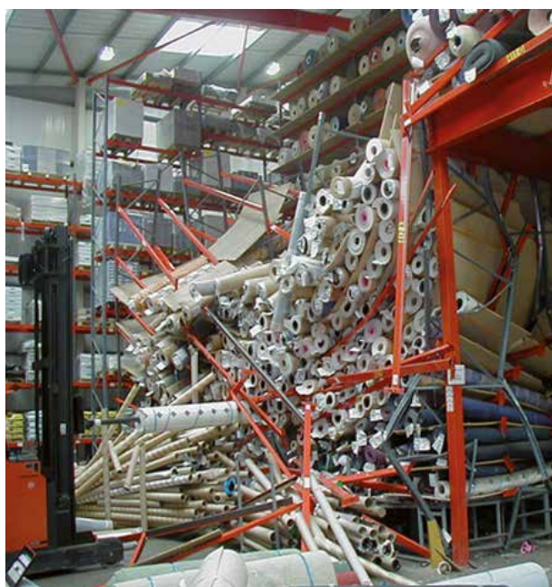
Rayonnages sans protection, percutes par un engin de manutention
