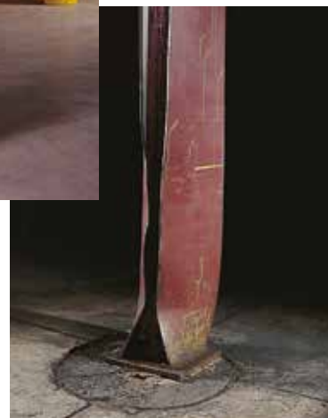
Pilier sans protection, percuté par les engins de manutention
