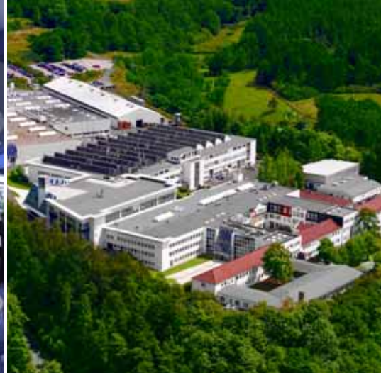
... et sur les 300 sites Rittal implantés dans le monde entier.
